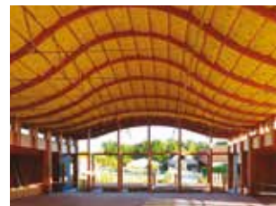
16 : Plafond en construction © DKL
